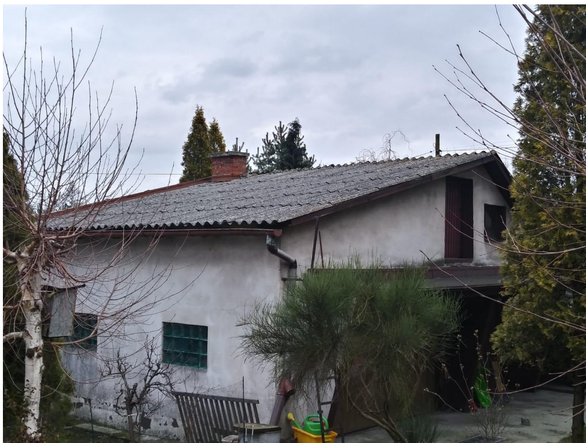
Rysunek 3 Dach pokryty płytami azbestowymi falistymi (budynek przykładowy)
