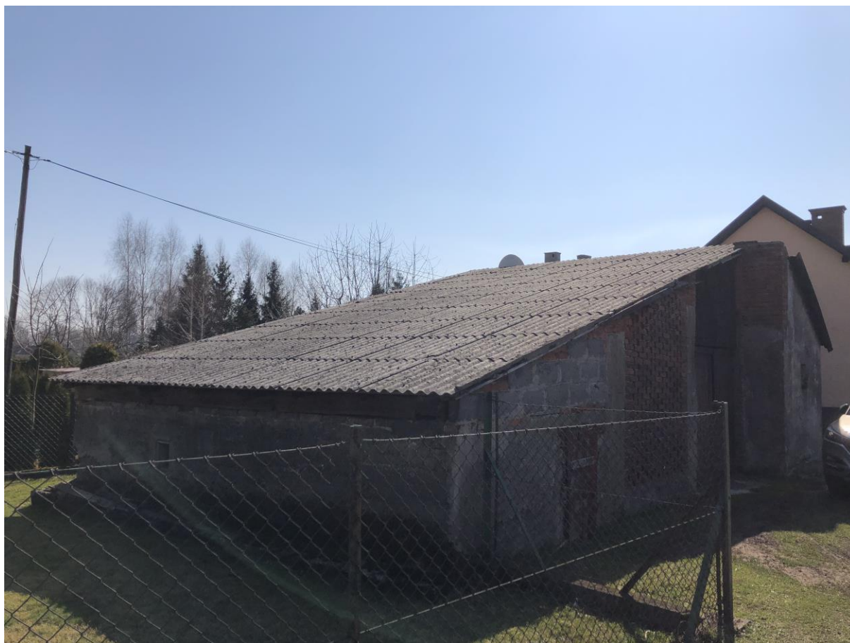
Rysunek 4 Dach budynku gospodarczego pokryty płytami azbestowymi falistymi (budynek przykładowy)
